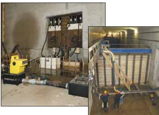
◀ Réalisés dans un alliage d'aluminium et ultra-légers, les remarquables vérins RAC506 Enerpac conviennent parfaitement à la mise en place des éléments de ce tunnel qui passe sous un cours d'eau (ligne de train à grande vitesse aux Pays-Bas).
